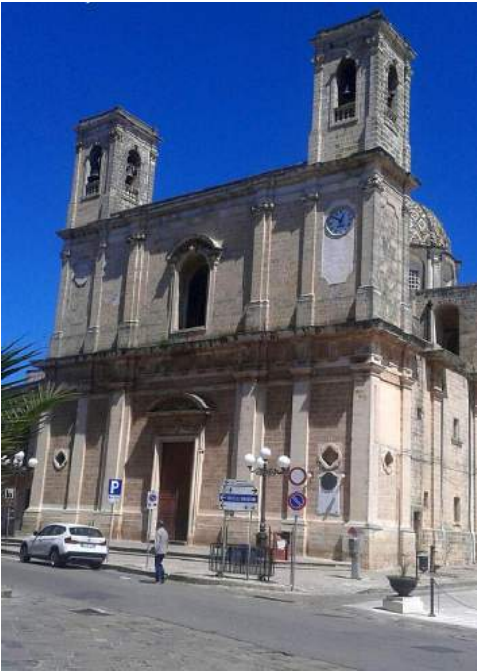
Chiesa madre, la facciata.
