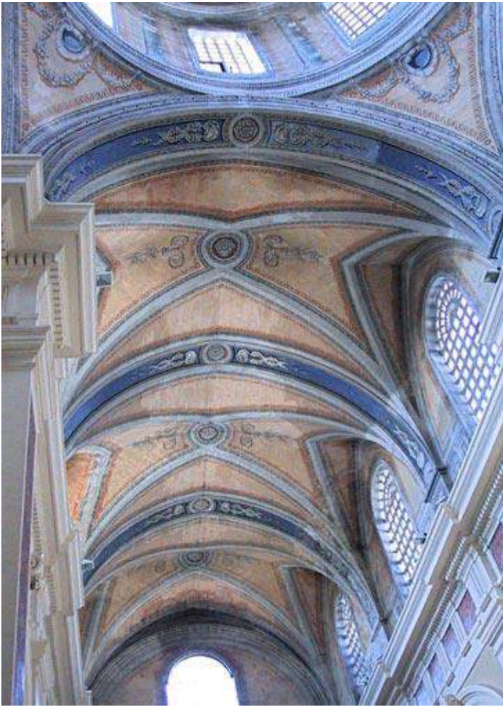
Chiesa Matrice, particolare delle volte.
