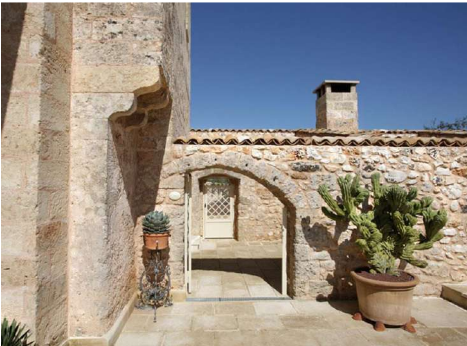
Masseria Saglietti , particolare.
